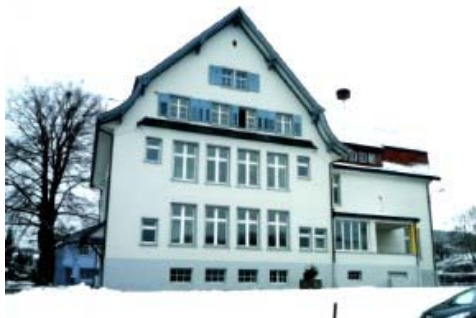
Das Haus 1 steht unter Denkmalschutz und muss trotz umfassender Erneuerung im Innern in seiner Bauart erhalten bleiben.
