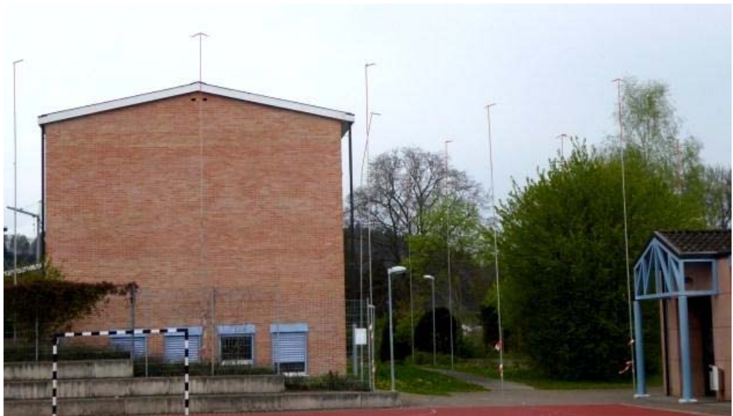
Bereits stehen die Bauvisiere für den Anbau beim Haus 4.
